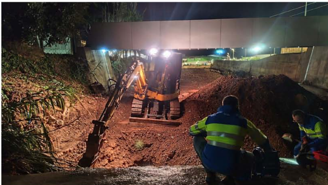
Operarios trabajando en la reparación de la tubería dañada en Balanegra. La Voz
