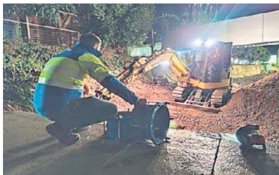
Trabajos para reactivar el acceso al agua potable en la localidad.
