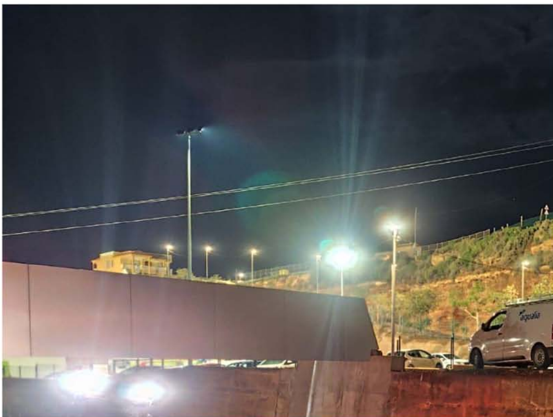
Obras para recuperar el abastecimiento de agua potable en Balanegra (Almería)
