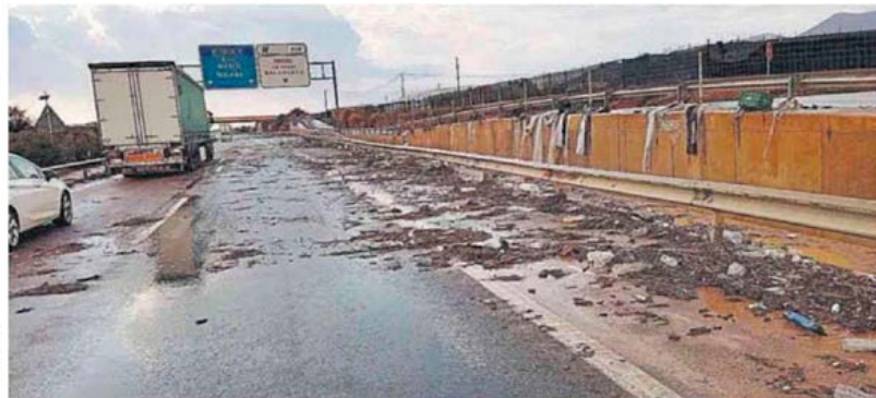
Daños en la Autovía del Mediterráneo tras la tormenta del pasado lunes por la tarde. LA VOZ
