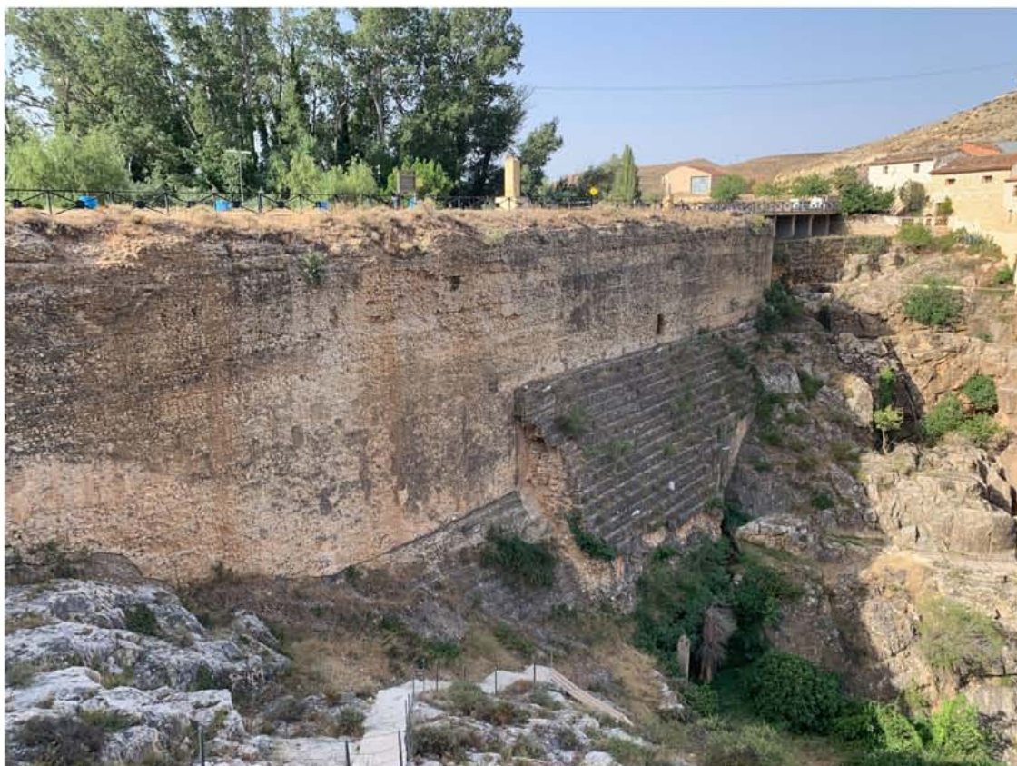
La presa romana de Almonacid de la Cuba, La Cuba
