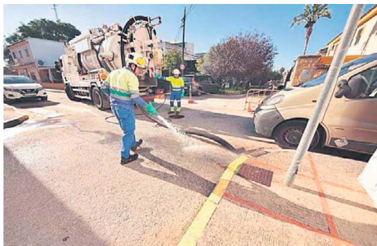
Tareas de limpieza en el alcantarillado e Guadalquivir, ayer por la mañana.
